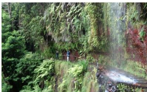
Figura 17: Vários aspetos da vereda que necessitam de ser reformulados: troços alagados e lamacentos, malha da guarda muito larga, ausência de proteção na zona da queda de água e tubos de PVC parcialmente exposto. Fotos realizadas por M. Pereira, jul 2016.
